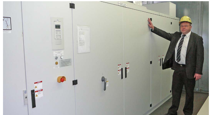
Mit den ACS 1000 drehzahlgeregelten Antrieben ließen sich bedeutende Energieeinsparungen realisieren.
