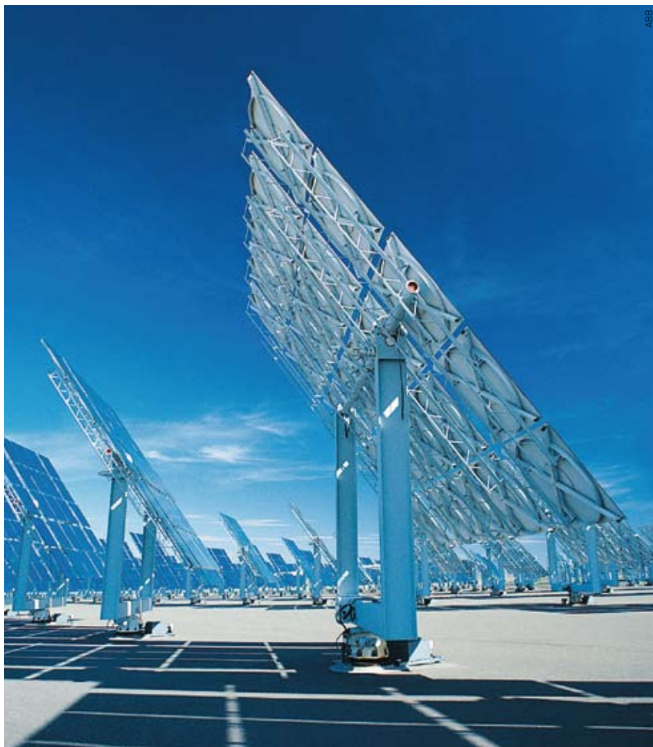
Die beweglichen Spiegel folgen der Sonne und konzentrieren die Strahlen in einem Punkt, um dort Wasser aufzuheizen.
