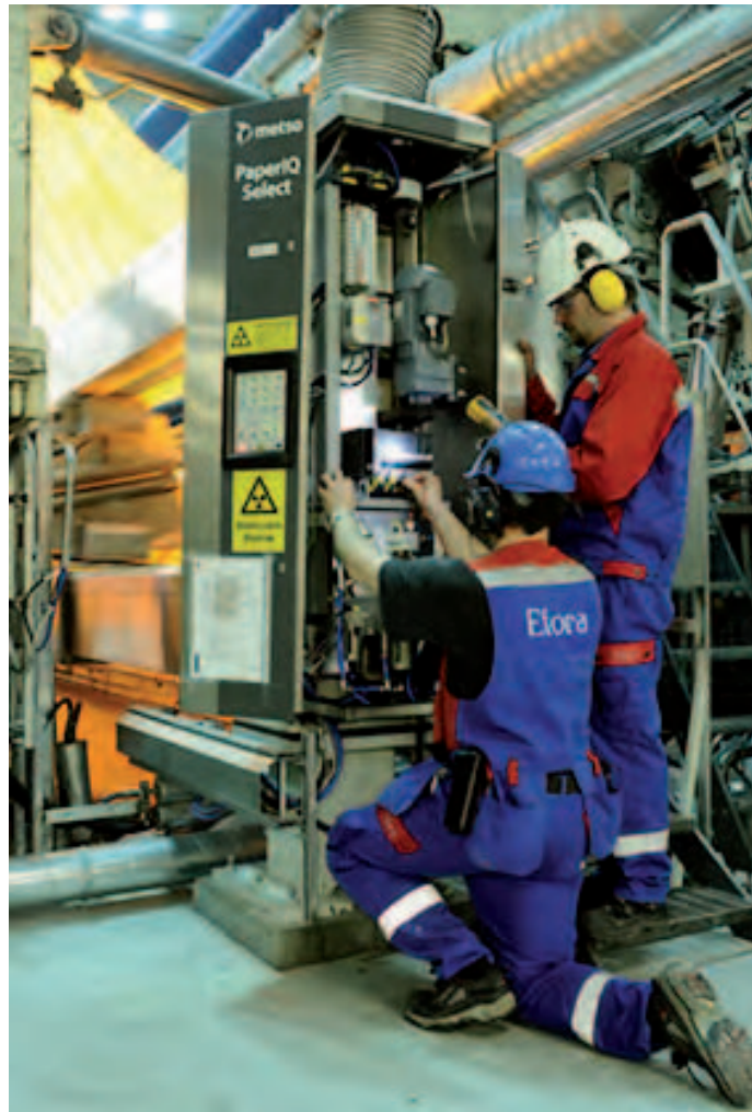
ABB Full Service® realiza a manutenção de todo o processo de produção da instalação industrial.
