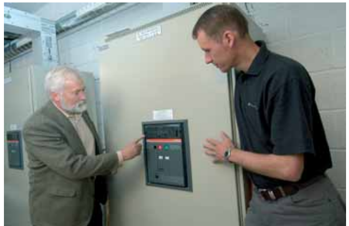
Geir Bothner (t.h) fra Skarnes Elektro inspiserer innstillingene på en av effektbryterne sammen med Svein Hertenberg fra ABB.
