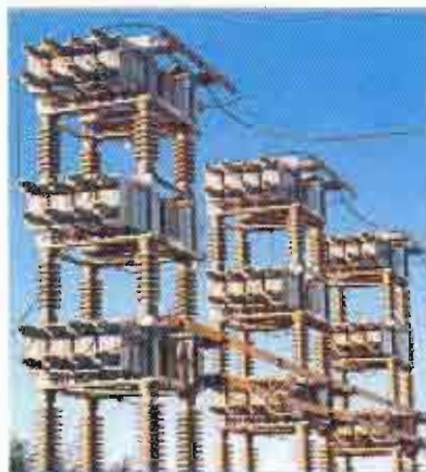
รูปที่ 1 (ก) การต่อใช้งานคาปาซิเตอร์แบบน้ำมัน
